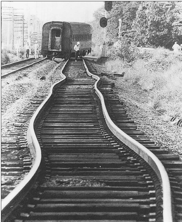
Obr. 19.8 Železniční koleje v Asbury Park, New Jersey, zkroucené vlivem teplotní roztažnosti za velmi horkého červencového dne.
